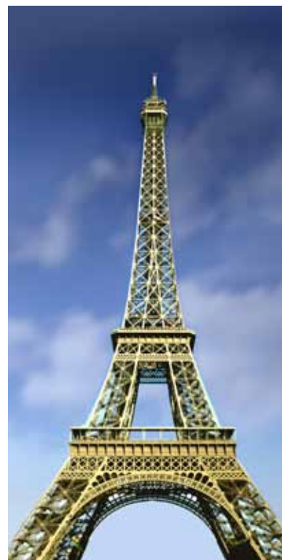
Eiffeltårnet stod ferdig i 1889 og består av 18.038 deler av smijern som er klinket sammen
