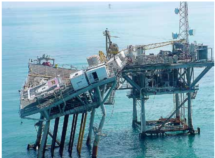
Plattform i Mexico-gulven etter orkanen Lili (oktober 2002), vindstyrke 65 m/s, bølgehøyde 17 m. Her har ikke materialene hatt tilstrekkelig styrke, og plattformen i forgrunnen har totalhavarert.
